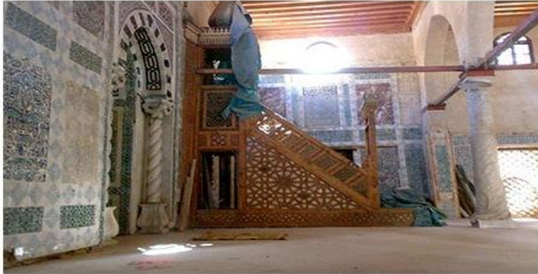
لوحة رقم (١١): الترميمات التي تجرى بداخل مسجد الجوربي من الداخل والتي توقفت في الوقت الحالي (الباحث)
