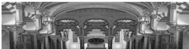
لوحة (٩) البلاط الاوسط لجامع قرطبة الأندلس ويظهر فيه مجموعة من العقود المتراكبة
