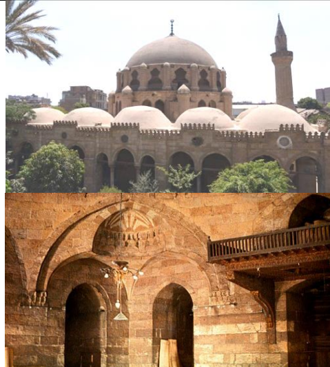
لوحة رقم (١٨): السقيفة التي تحيط بقبة جامع السنانية ببولاق على شكل حرف (U) والحنية الثلاثية بمناطق انتقال القبة (الباحث)
